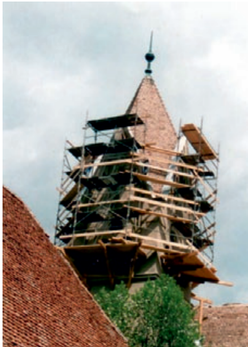
Renovierungsarbeiten am Kirchturm
