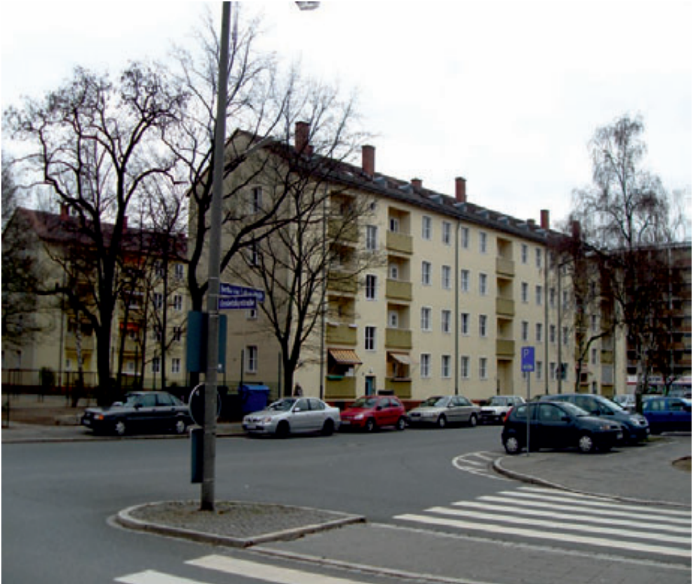
Durchgangsstelle für Aussiedler in Nürnberg, in der Berta von Suttner Straße, Übergangwohnheim
