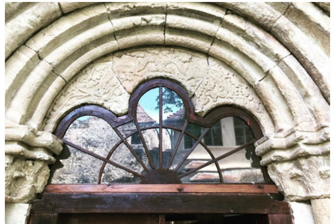
Das Renovierungsprojekt an der Kirchenburg in Draas wartet auf seine Fortführung, wie es heißt. Bild: Thomas Petri
